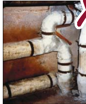
Asbestos lagging
